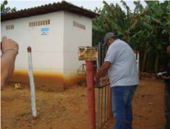
Figura 117: Edificação utilizada para armazenamento de agrotóxicos com placas indicativas de perigo e acesso restrito e aberturas para ventilação que impossibilitam a entrada de animais
