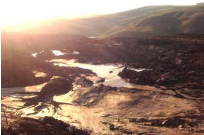
Figuras 169 e 170: Ruptura de barragem de rejeito de minério de ferro ocorrida em setembro de 2014 em mineração no município de Itabirito-MG (Arquivo do autor)
