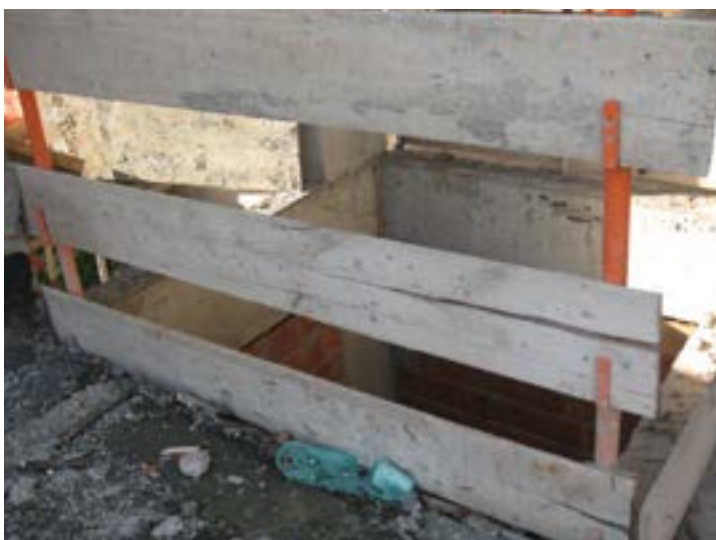
Figura 9: Guarda-corpo de madeira com rachaduras
