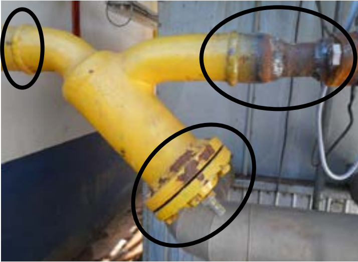
Figura 123: Exemplo de ponto crítico (flange e solda)
