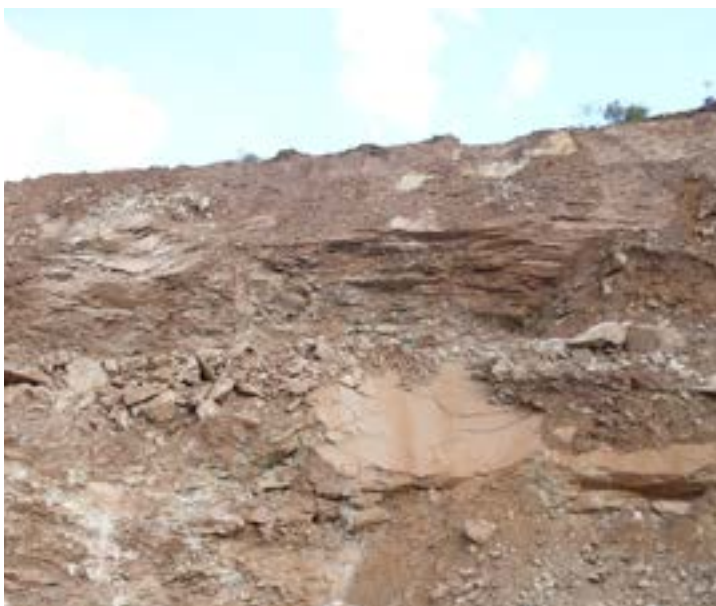
Figuras 159 e 160: Maciços desarticulados com taludes negativos (Arquivo do autor)
