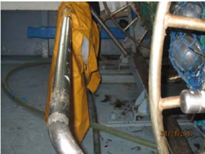
Figuras 183 e 184: Proteções para o contato acidental com partes perigosas (Fonte: Inspeção do Trabalho da Espanha)
