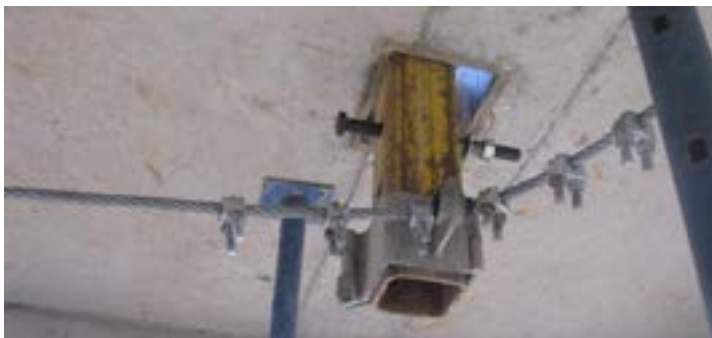
Figura 86: Linha de vida horizontal presa por meio de braçadeiras que podem correr para baixo por ocasião da retenção de uma queda
