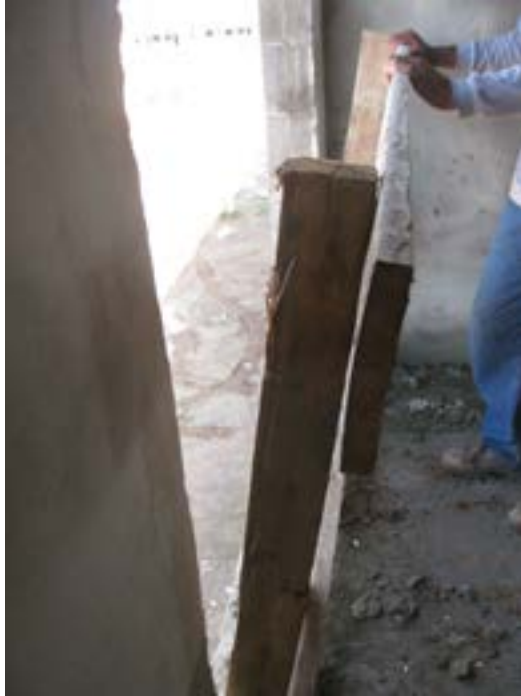
Figura 10: Proteção dos vãos para acesso de materiais solta, podendo ser removida facilmente
