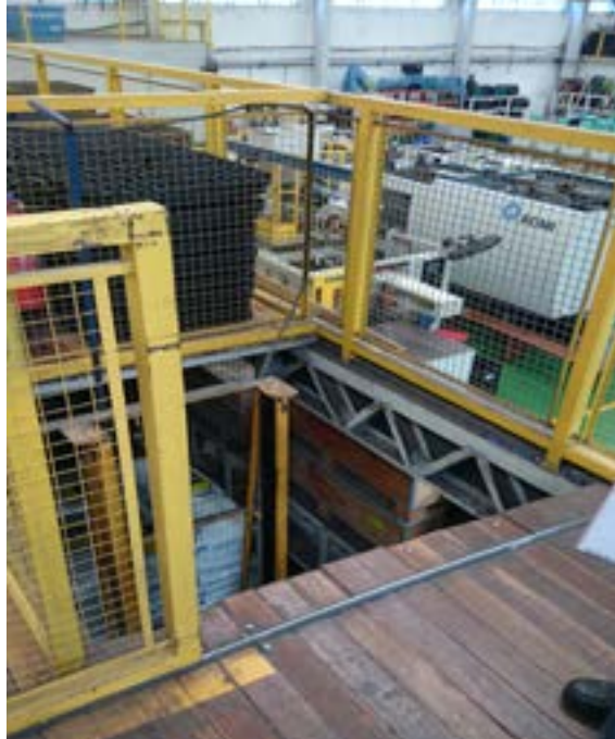
Figura 198: Embora existentes, portões posicionados junto ao vão do monta-carga em pavimentos elevados não possuem dispositivos de segurança que garantam a abertura da barreira apenas quando nivelada a cabine com o pavimento
