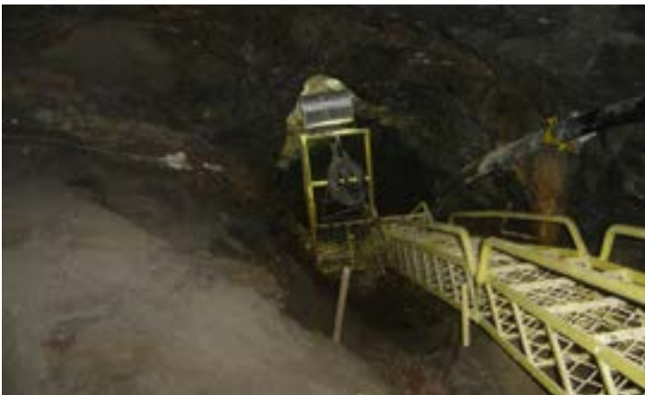
Figura 173: Escada para saída de emergência de mina subterrânea (Arquivo do autor)
