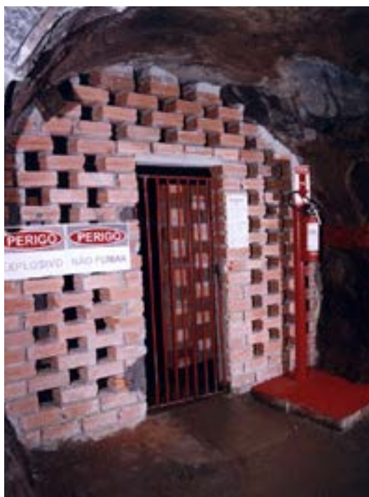
Figura 142: Entrada e interior de depósito de explosivo em subsolo
