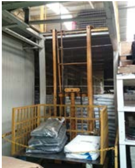
Figura 196: Compartimento de cargas aberto; faces laterais e traseira do fechamento da cabina cuja altura não acompanha uma eventual limitação para o empilhamento de cargas; abertura frontal da cabina que favorece a queda de materiais sobre o trabalhador
