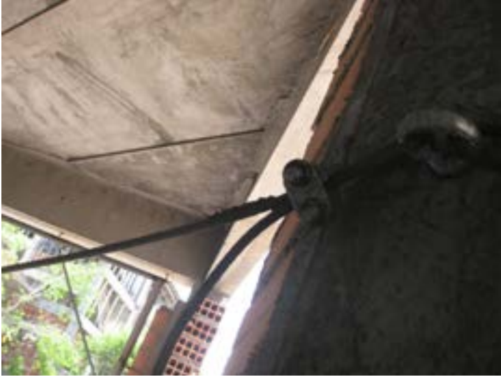
Figura 73: Linha de vida horizontal com cabo de aço preso por apenas um grampo do tipo leve em olhal de ferro fundido
