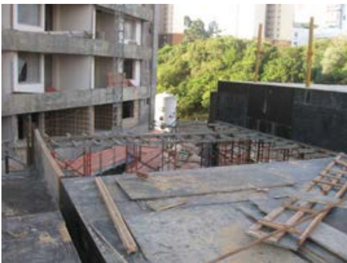
Figura 76: Montagem de formas (a linha de vida horizontal não oferece proteção contra quedas da borda da área que está sendo assoalhada)
