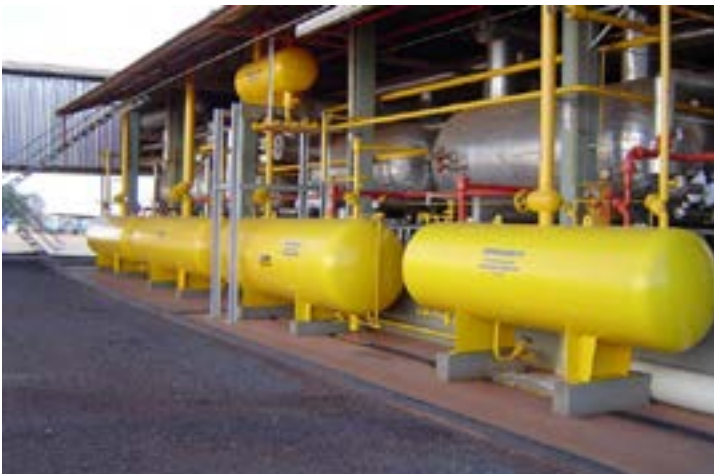
Figura 120: Uma sala de máquina do sistema de refrigeração com amônia
