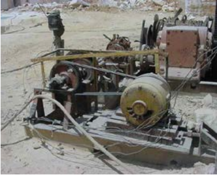
Figura 148: Partes móveis sem proteção (Arquivo do autor)
