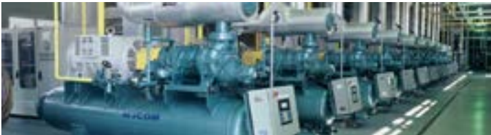
Figura 121: Linha de compressores de linha de grande porte
