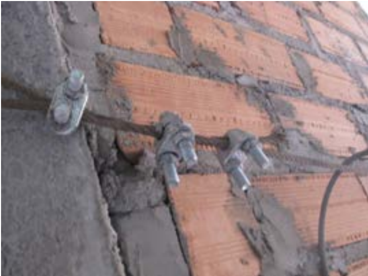
Figura 74: Linha de vida horizontal presa por grampos do tipo leve
