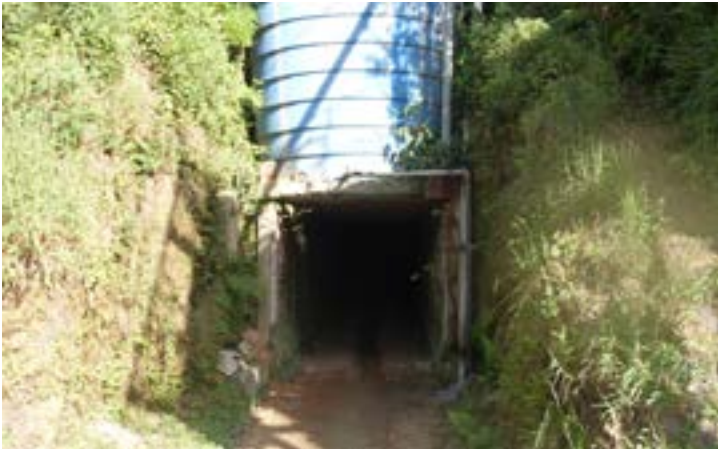
Figura 172: Saída de emergência de mina subterrânea (Arquivo do autor)
