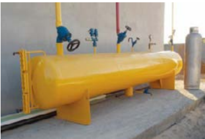
Figura 122: Reservatório de amônia típico (vaso de pressão)
