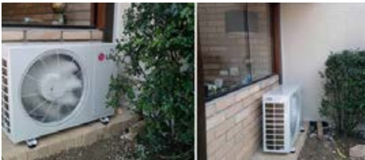
Figura 23: Aparelhos de ar-condicionado ao nível do solo
