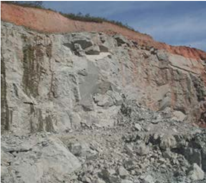
Figuras 161 e 162: Quebras mecânicas em maciços (Arquivo do autor)
