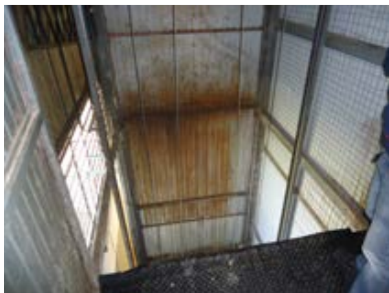
Figura 199: Elevador de cargas de estabelecimento supermercadista; acesso à zona de movimentação da cabine proporcionado pela simples abertura do portão, sem dispositivos que exijam o nivelamento da cabine com o pavimento elevado ou que bloqueiem a movimentação vertical do compartimento de carga
