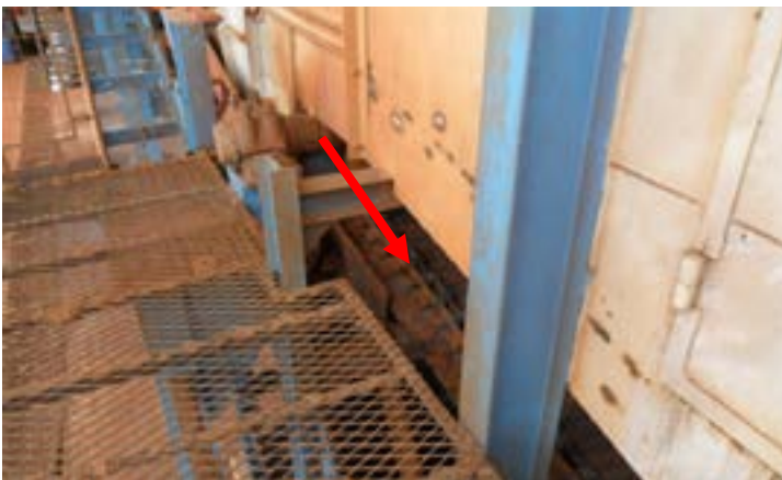
Figuras 109 e 110: Piso com abertura (seta) sem proteção periférica
