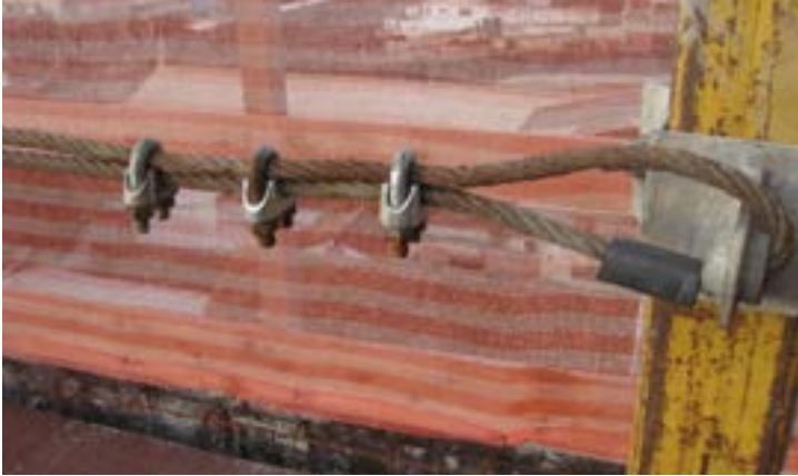
Figura 88: Laços sem sapatilhas (o cabo se dobra excessivamente, danificando-o e diminuindo sua resistência)
