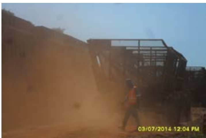
Figura 91: Um trabalhador balizador circulando próximo aos veículos (observe a poeira no ambiente)
