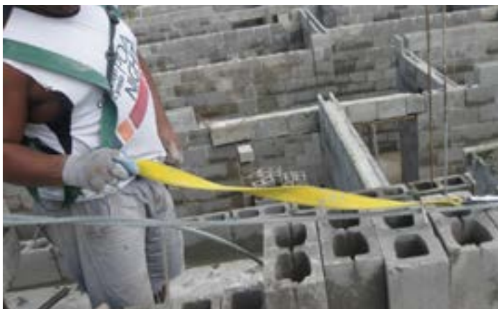
Figura 79: Montantes da linha de vida arrancados (os chumbadores podem ser retirados dos furos; não oferecem fixação segura)
