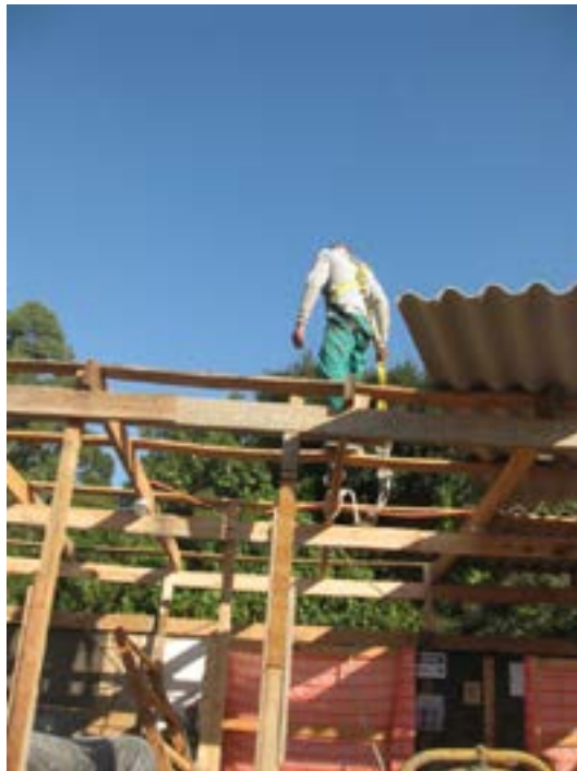
Figura 70: Talabarte ligado em prolongador (em caso de queda, o trabalhador alcançaria o solo antes que a queda fosse retida)
