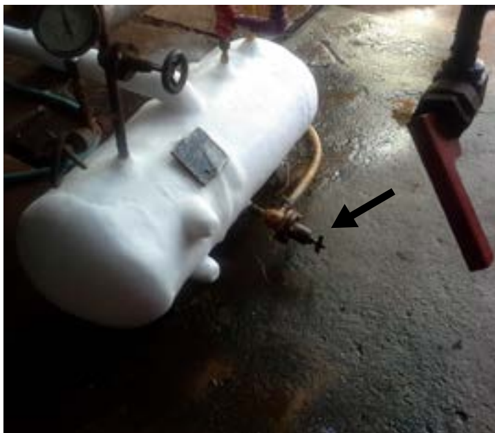
Figura 124: Válvula de drenagem sem fecho instantâneo automático
