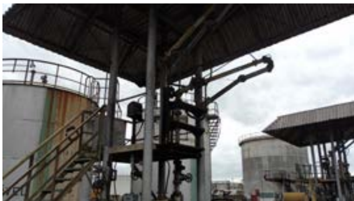
Figura 130: Vista geral de plataforma de carregamento em sistema top loading , observando-se a ausência de sistema de recuperação de vapores para a minimização dos riscos decorrentes das interações químicas
