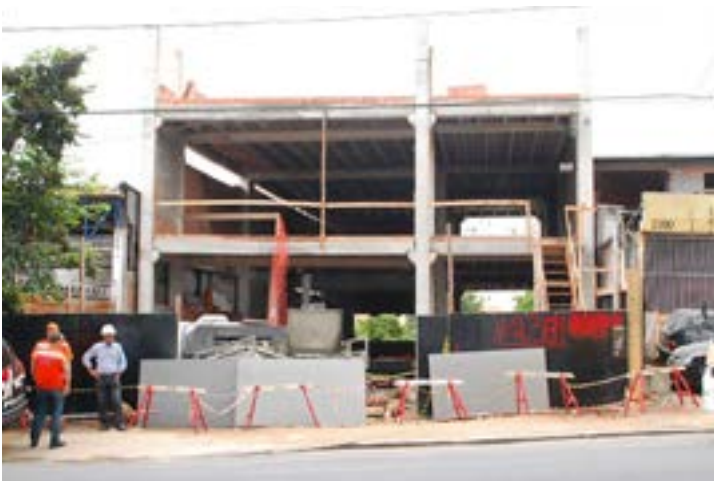
Figura 7: Guarda-corpo frágil e improvisado no 2º pavimento
