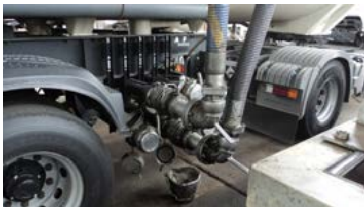
Figura 131: Vista geral de carregamento de caminhão-tanque em sistema bottom loading , que, mesmo sendo mais protetivo que o anterior, não elimina a exposição das pessoas ao benzeno
