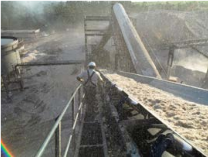
Figura 102: Esteira de bagaço de cana sem proteção nas partes girantes
