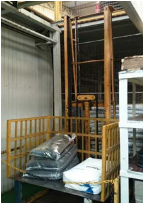
Figura 197: Plataforma de elevação de cargas sem projeto ou laudo estrutural que determina a limitação máxima de capacidade de transporte de materiais; ausência de sinalização de segurança que expresse essa limitação de capacidade
