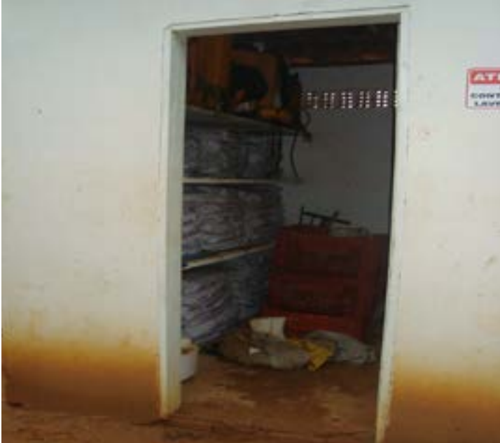
Figura 119: Embalagens de agrotóxicos armazenadas diretamente no chão
