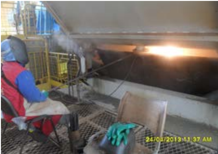
Figura 106: Operação de chapiscamento manual em moenda sem sistema de ventilação local exaustora
