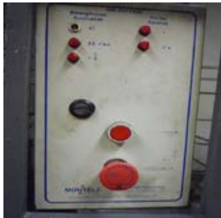
Figura 201: Painéis de comando com deficiente ou apagada sinalização das funções das botoeiras e dos alertas luminosos; concentração das funções sobe/desce em único botão; ausência de dispositivo reset
