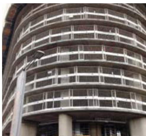
Figura 48: Guarda-corpo de altura dupla (proteção contra queda de pessoas e de materiais)
