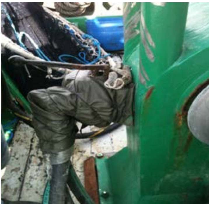
Figura 181: Alavanca de acionamento de guincho desprotegida
