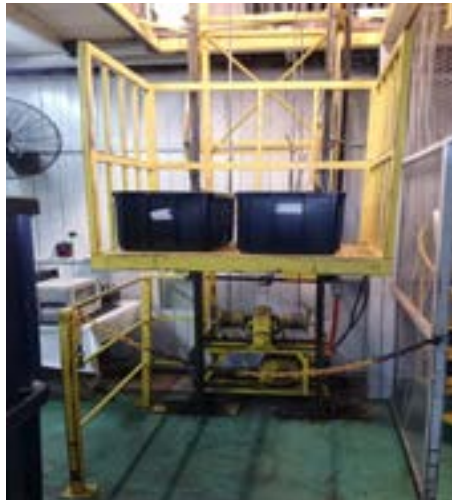
Figura 194: Acesso livre e desimpedido do trabalhador à zona de movimentação vertical da plataforma de carga; barreiras físicas laterais ineficientes para impedir a inserção de segmentos corporais na zona perigosa de movimentação vertical de cargas, favorecendo um efeito guilhotina na passagem da cabine junto às barreiras laterais
