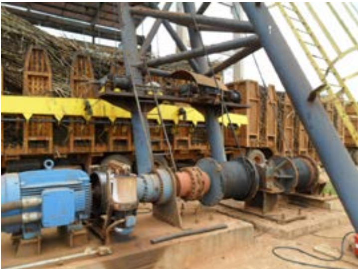
Figura 103: Motor elétrico de um hilo com eixo acoplado (partes girantes e cabos de aço acessíveis sem nenhuma proteção periférica)
