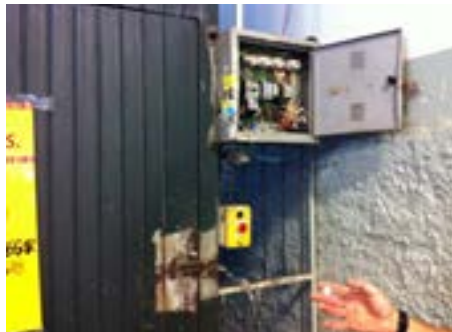
Figura 200: Armários elétricos abertos, sem identificação dos circuitos; acomodação desordenada dos componentes elétricos e não respaldada por esquema elétrico devidamente documentado; inexistência de aterramento das partes do equipamento compostas por materiais condutores, sujeitas a energização acidental
