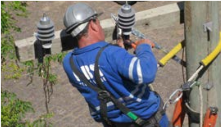
Figura 82: Trabalho em poste com talabarte de posicionamento sem uso de sistema de retenção de quedas
