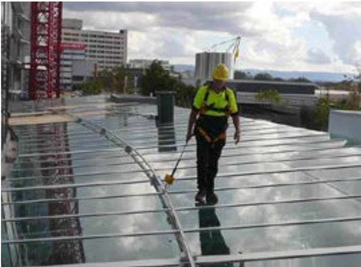
Figura 53: Linha de ancoragem horizontal rígida. Fonte: CAI Safety Systems
