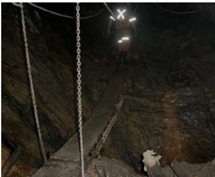
Figuras 157 e 158: Aberturas com risco de queda de pessoas (Arquivo do autor)
