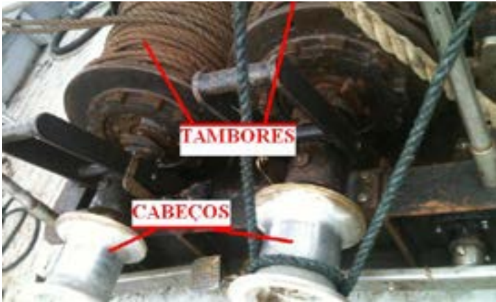
Figura 177: Guinchos de pesca em que se destacam tambores (geralmente com cabos de aço) e cabeços (onde, em regra, se utilizam cabos de nylon e ainda não se tem notícia da possibilidade técnica de protegê-los de forma a atender à NR 12 de forma estrita)
