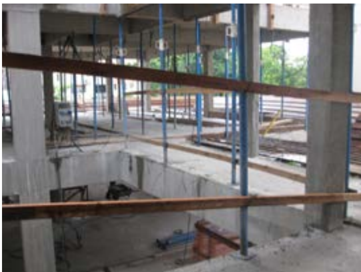
Figura 8: Guarda-corpo improvisado, ausência de projeto, travessões frágeis, presos com arame, sem rodapé, montantes não estão fixados na laje
