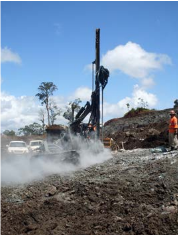
Figura 163: Perfuração a seco em mina a céu aberto de minério de ouro (Arquivo do autor)
