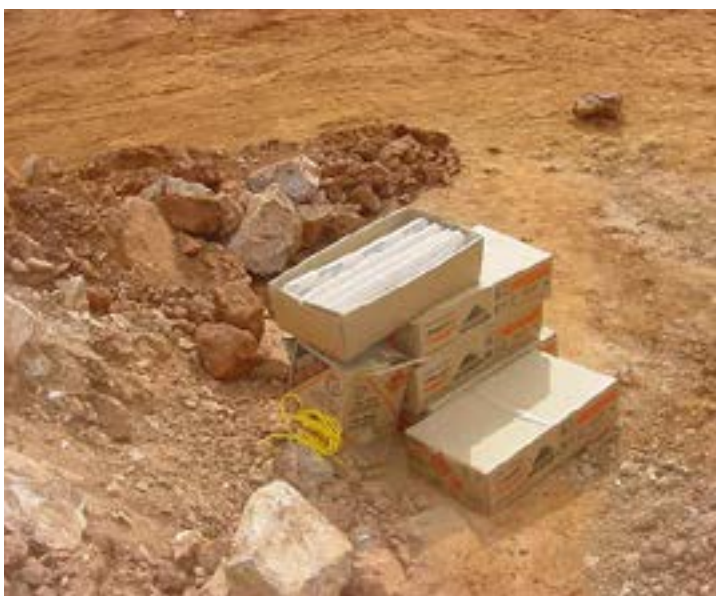
Figura 168: Explosivos não utilizados deixados em local próximo ao trânsito de equipamentos (Arquivo do autor)
