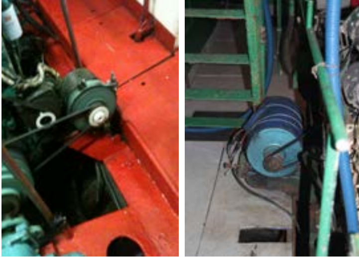
Figuras 185 e 186: Transmissões de força desprotegidas nas casas de máquinas junto aos locais de circulação de trabalhadores
