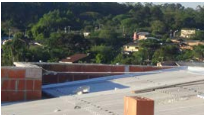
Figura 71: Sistema de ancoragem improvisado para sistema de proteção individual contra quedas de montadores de andaime, feito com uma corda amarrada através de um furo na parede, passando ao redor de cantos vivos (não havia projeto do sistema de proteção individual)
