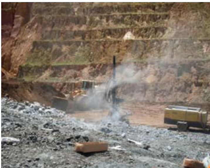
Figura 167: Situação de grave e iminente risco em atividades de perfuração concomitantes com carregamento de explosivos (Arquivo do autor)
