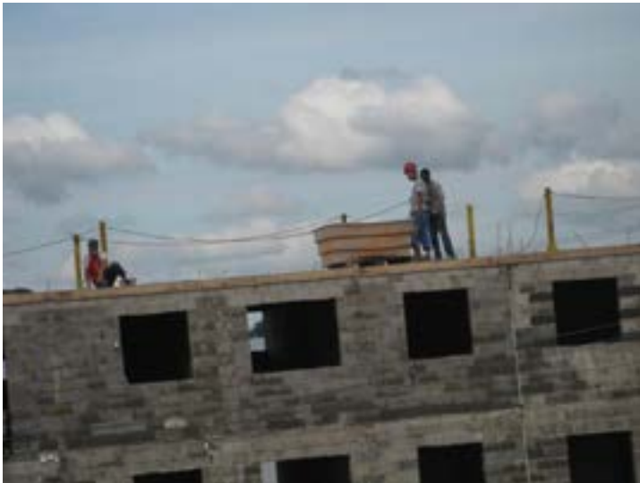
Figura 78: A linha de vida horizontal não protege (em partes está derrubada, e os trabalhadores não se conectam a ela)
