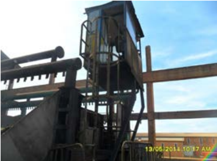
Figura 111: Cabine de operação de mesa alimentadora com acesso precário (escada tipo marinheiro), feita de material metálico e exposta ao sol sem climatização, isolamento acústico e amortecimento para a vibração decorrente do funcionamento da mesa.
