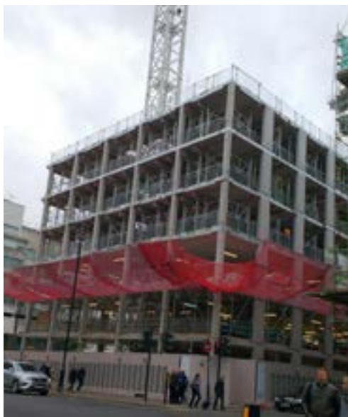
Figura 49: Proteção contra queda de pessoas com guarda-corpo, complementada com rede de segurança contra queda de materiais
