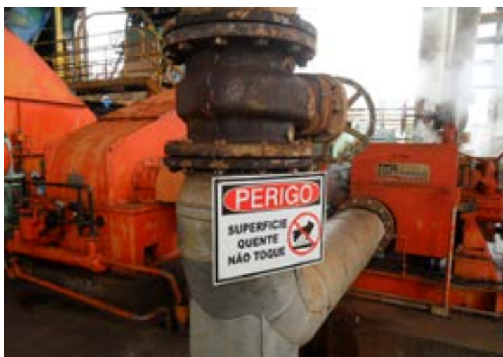
Figura 105: Superfície aquecida acessível (a placa de advertência não é medida de proteção suficiente)
