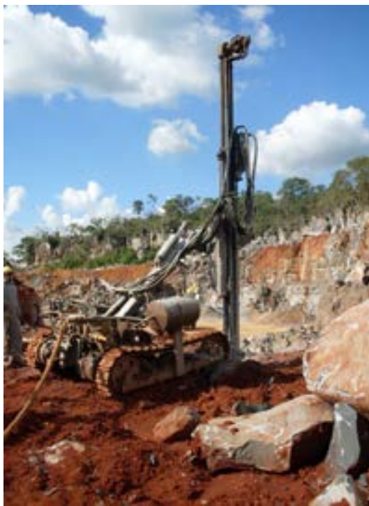
Figura 164: Perfuratriz dotada de sistema de umidificação (Arquivo do autor)
